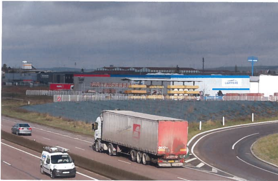
Les délaissés de la rocade sont devenus en quelques mois la vitrine d'une zone industrielle qui amorce une profonde restructuration
