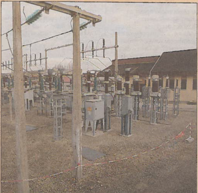
Le poste source d'ERDF va être rénové. Trois ans de travaux et 5 M€ seront nécessaires
