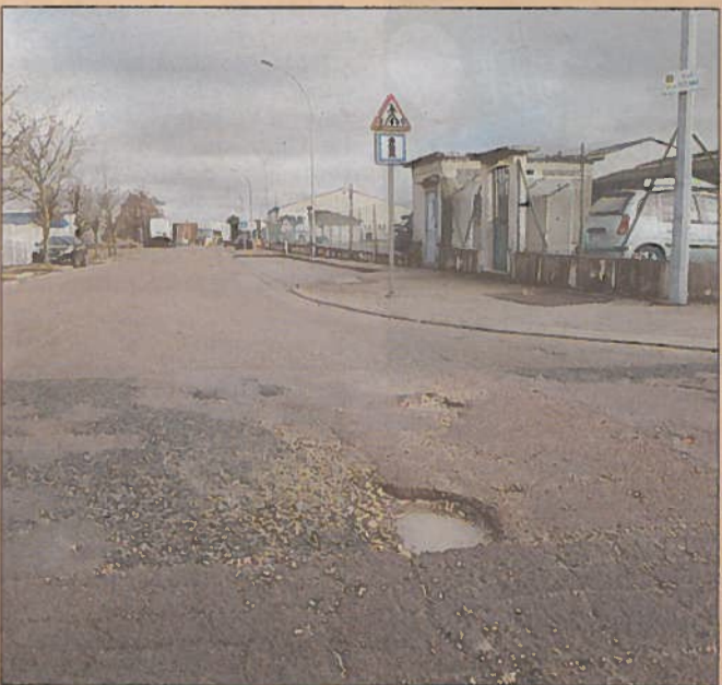
Les voiries seront reprises dès cette année. Le calendrier des travaux a été arrêté
